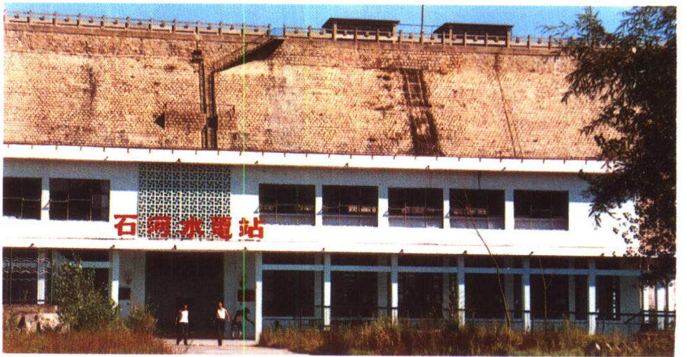
上: 北山电厂 中: 徐庄22万站区 下: 石河水电站
