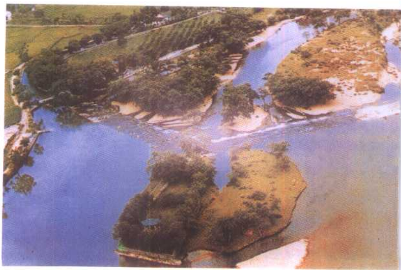
上图：泾惠渠渠首滚水坝 殷鹤仙 摄
