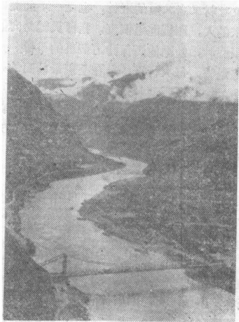
大渡河上的鋼索吊橋
