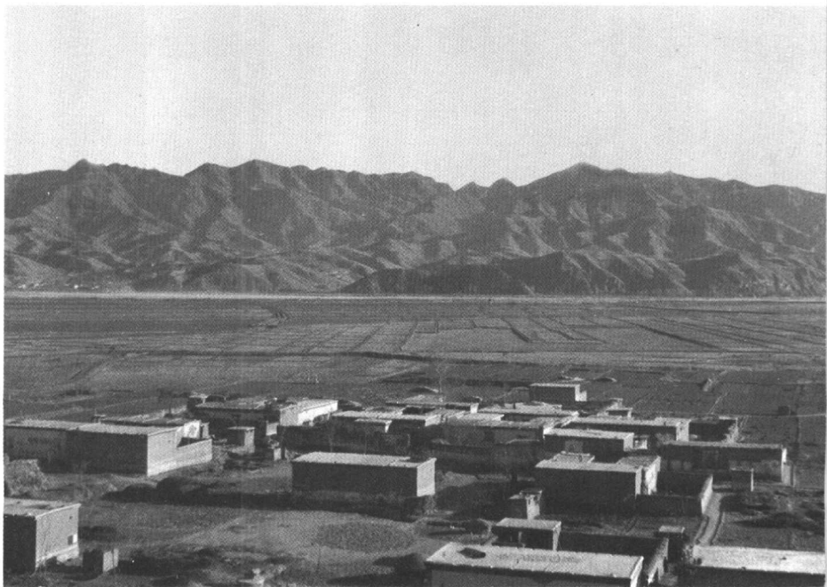
西柏坡村子正中及村前的三千亩稻田,是毛泽东等五大书记经常散步的地方(1958 年修建水库后已不存在)
