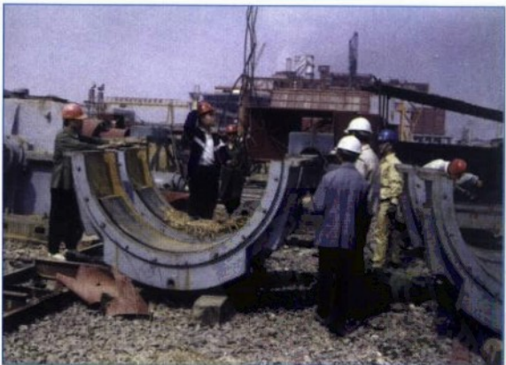
安庆电力技工学校实习现场
