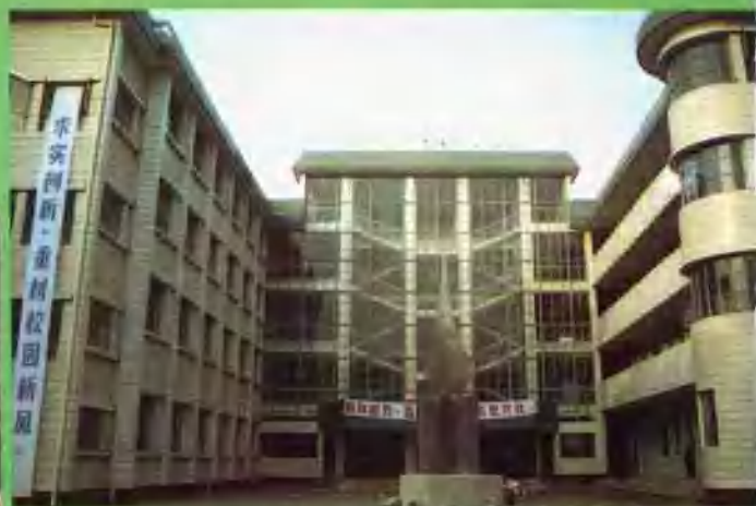
新落成的五条街小学教学楼
