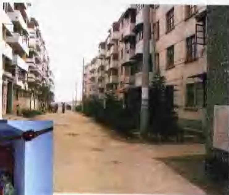
建成“广厦村”灾民安置房
