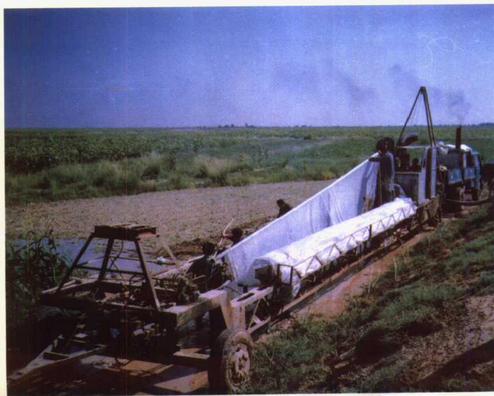
排水沟埋塑膜防塌施工现场
