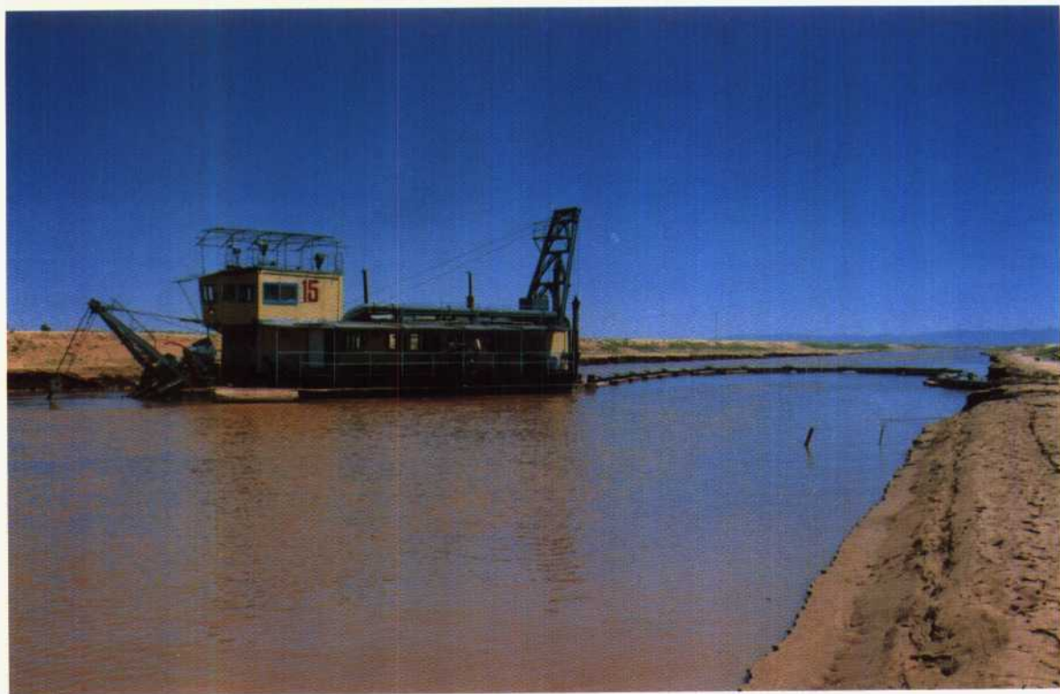
总排干扩建施工
