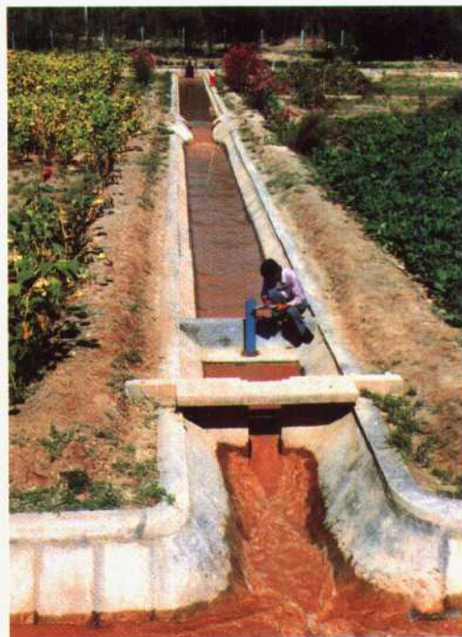
永济量水试验场一角
