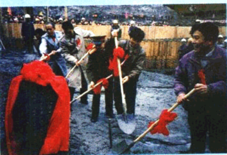
石板水电站开工典礼
