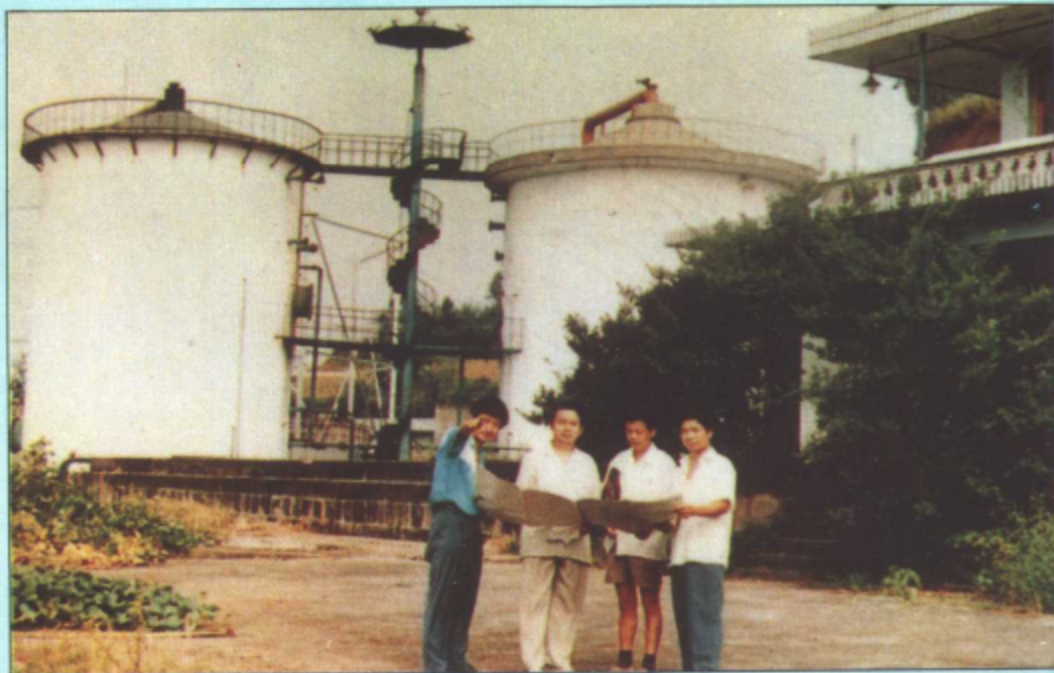
► 县燃气公司水煤气生产车间
