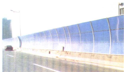
图5-14 上海市内高架公路上采用的塑料隔音板（阳光板）
