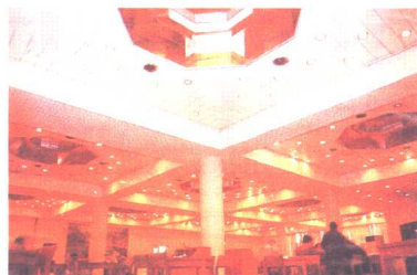
图4-8 PVC中空异型板吊顶
