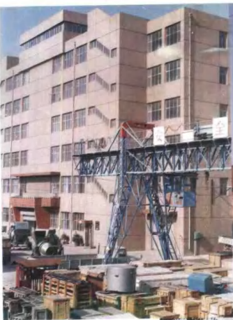
↑ 石家庄市机电设备公司 高层仓库
