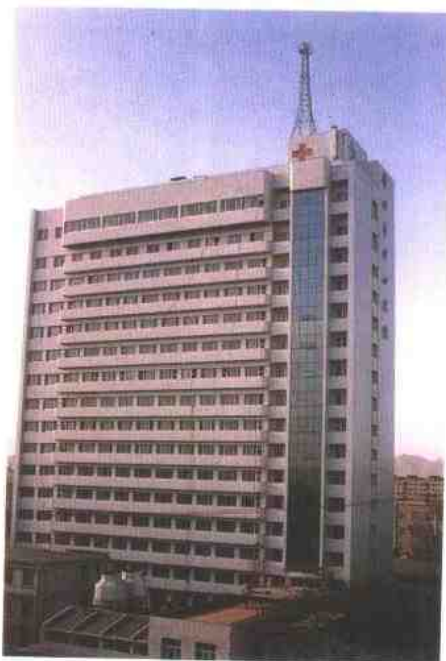
▷中心医院外科病房楼
