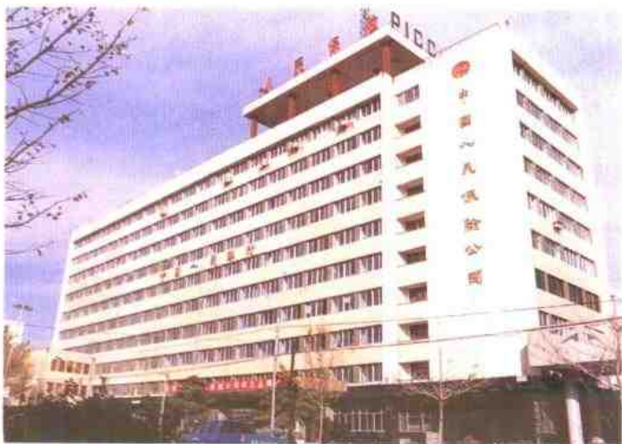
△中国人民保险公司锦州市支公司办公楼
