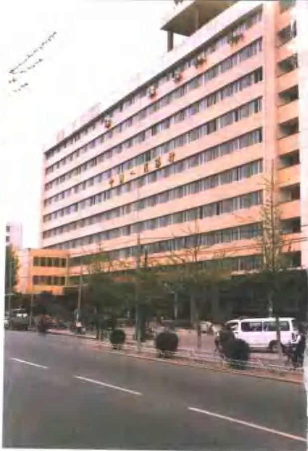
▷人行办公大楼
