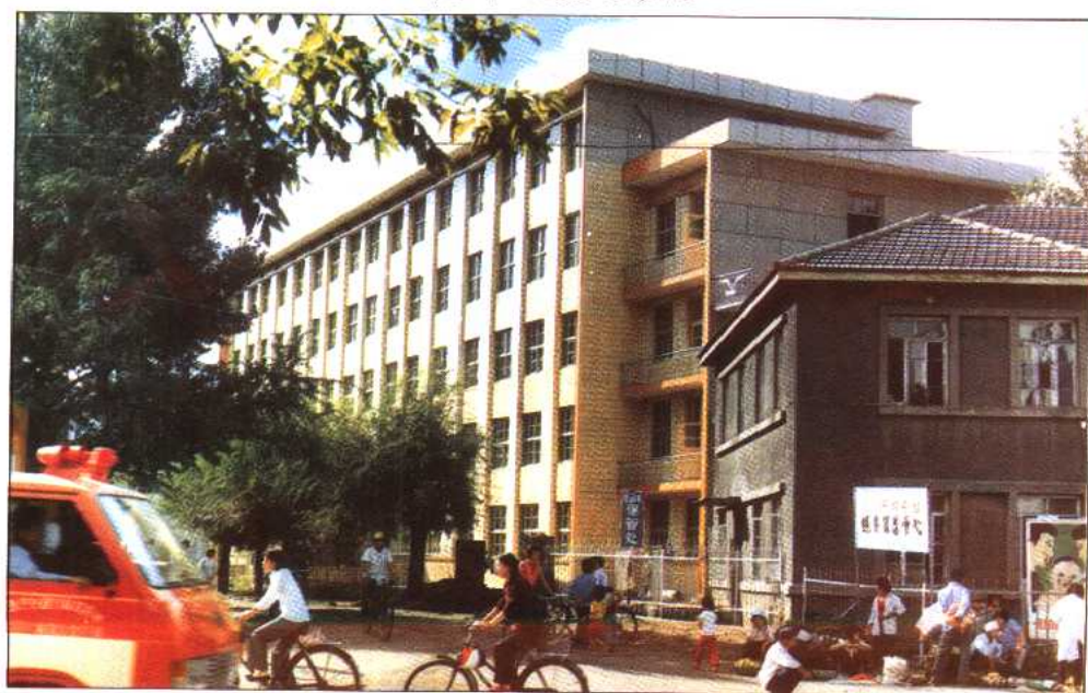
县医院住院楼
