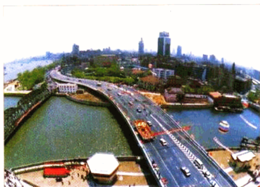
吴淞路闸桥全景
