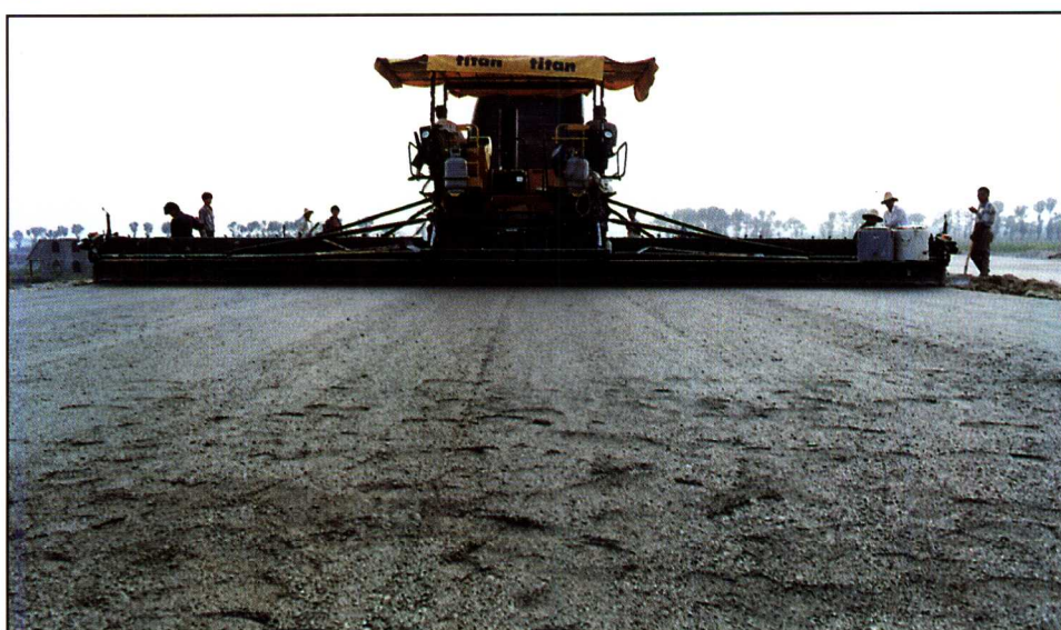
廊坊市公路工程有限公司用德国进口伏格洛摊铺机正在京沈高速公路施工
