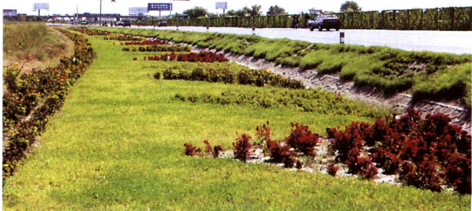
公路防护工程
