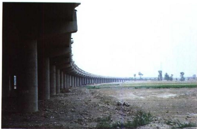
如卧龙盘旋，公司第一监理部监理的“精品”工程太原南过境高速公路十里长桥已成为绚丽的城市风景
