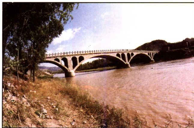
70年代初至80年代末，平山县发挥山区石头多的优势，大搞石拱桥建设，被称为“平山石桥热”。如今200多座石拱桥如银链般飘落在平山大地，使天堑变通途。图为小觉大石桥。
