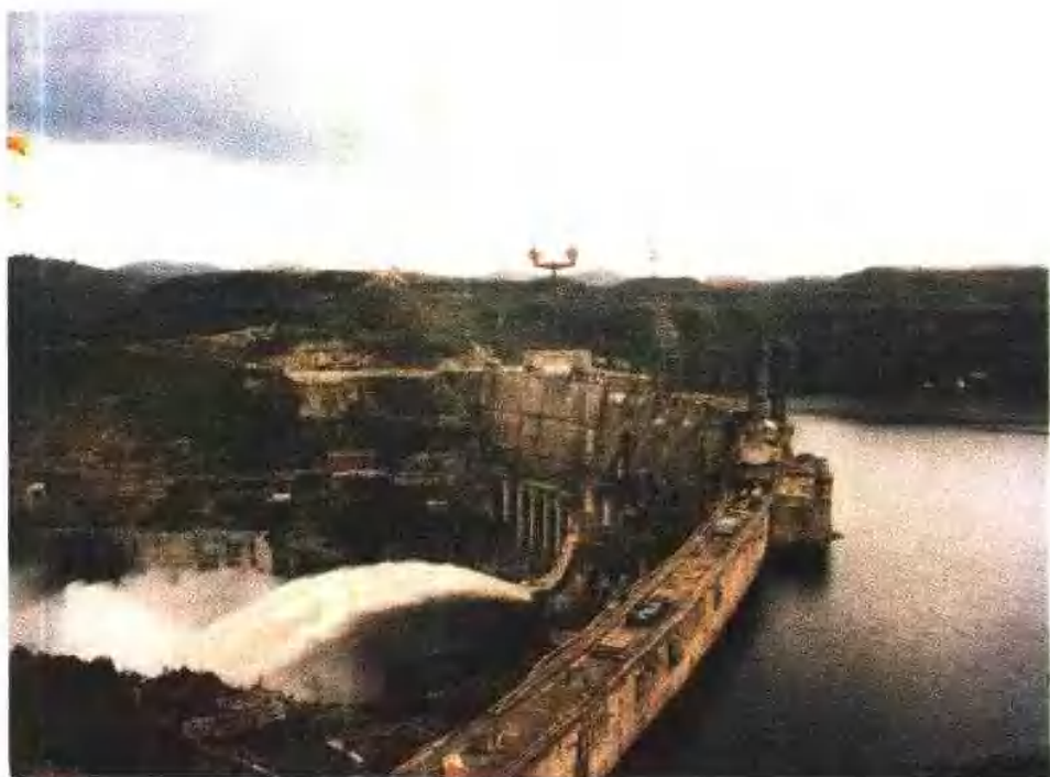
白山水电站大坝
