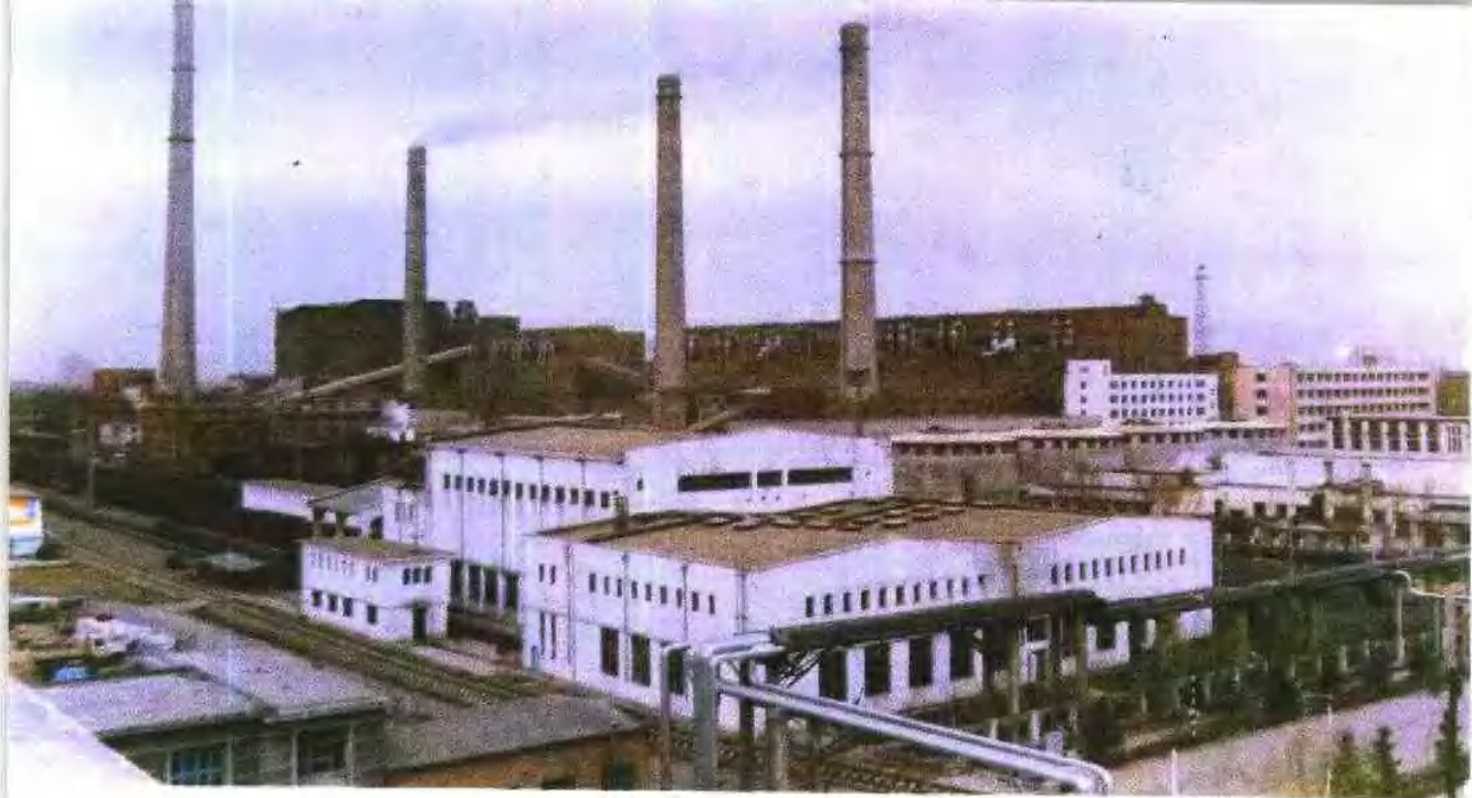
吉林热电厂外貌
