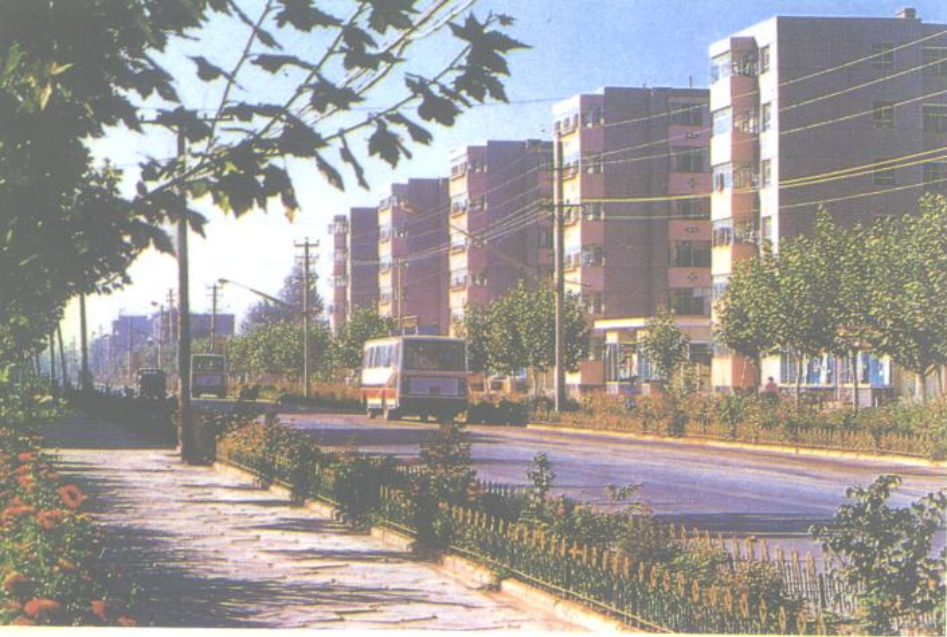
新建住宅楼群
