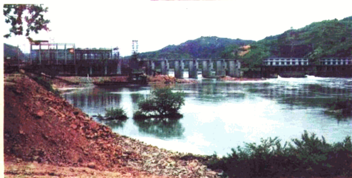
兴建中的永兴电站
