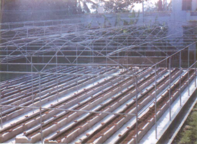
哈密瓜无土栽培 用的大棚结构
