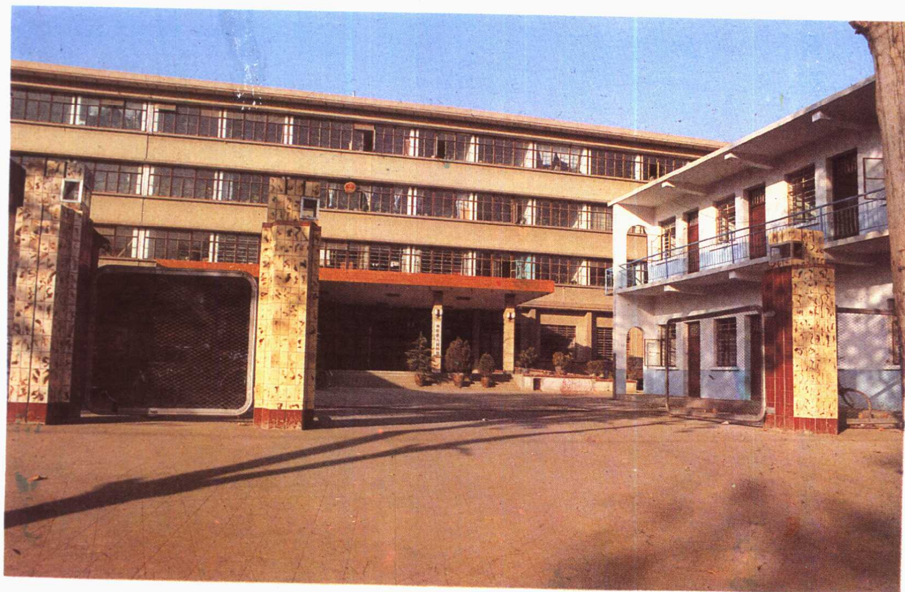
南阳县人民政府办公楼
