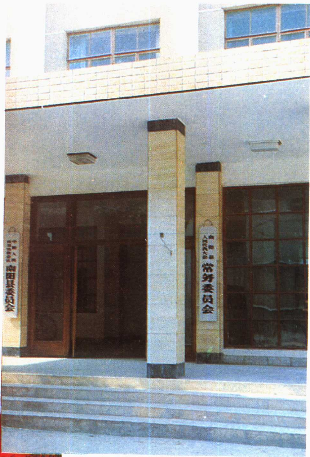
县人大常委会 人民政协南阳县委员会办公楼
