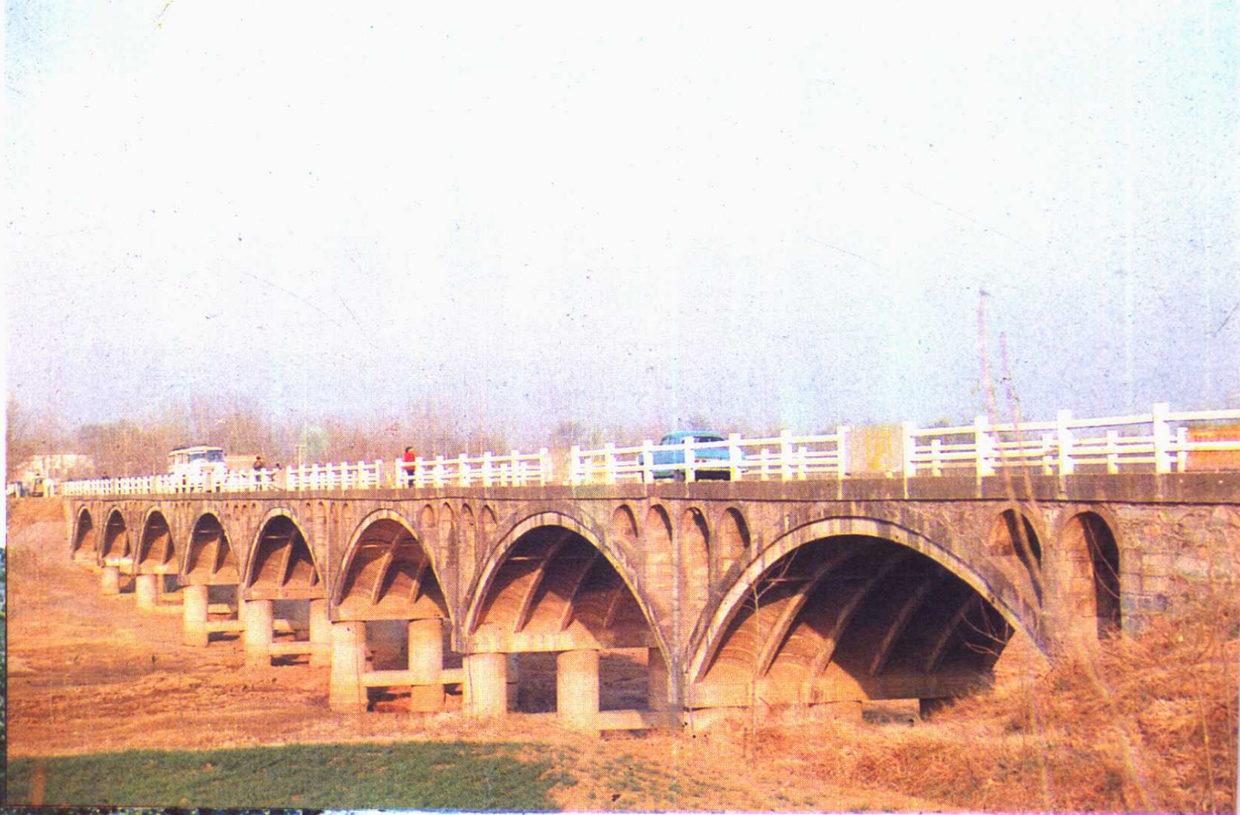
郑孟公路上的潦河大桥
