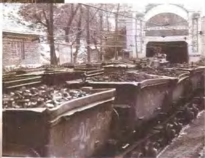
宣化钢铁公司龙烟铁矿 1080 平峒坑口
