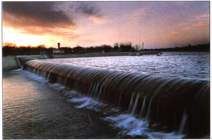
净肠河橡胶坝
