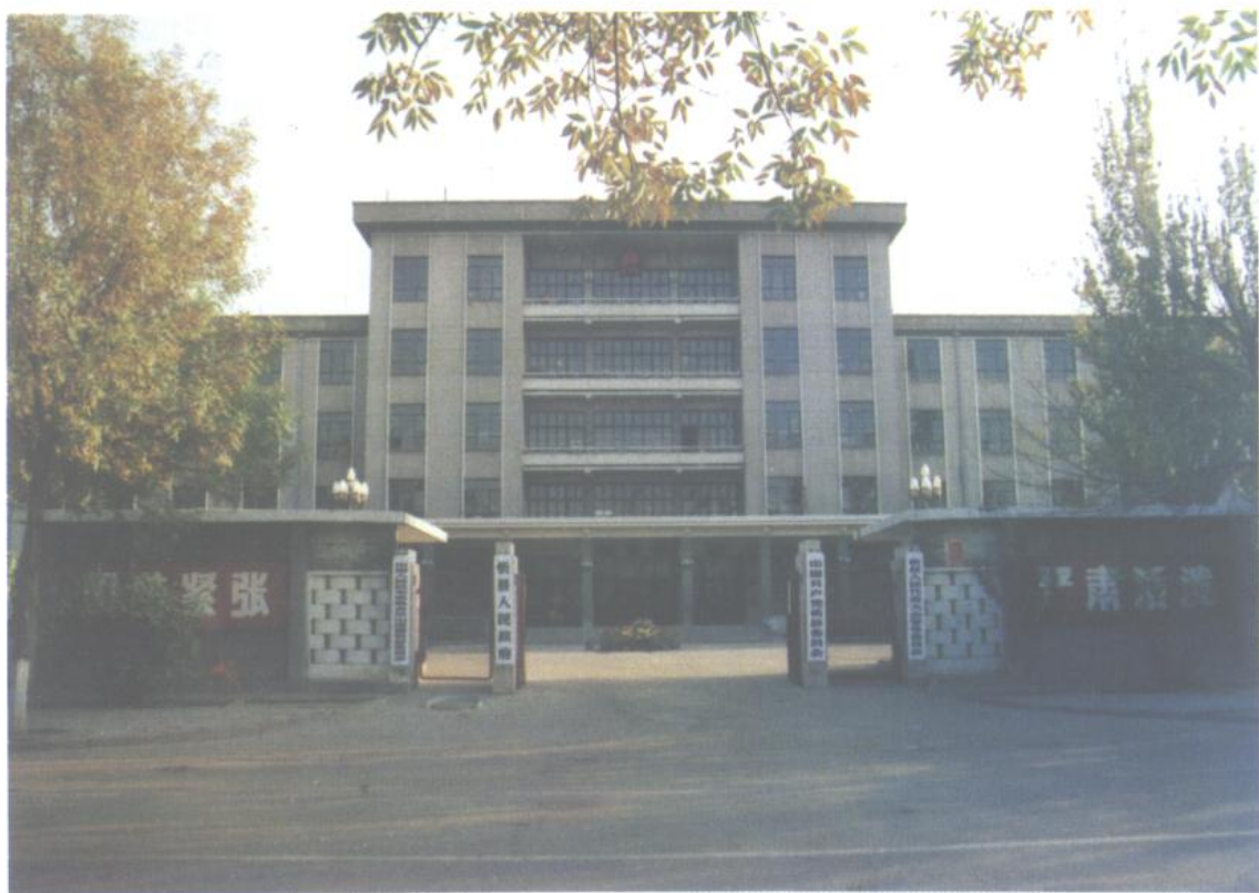
● 中共忻县县委、忻县人民政府大楼
