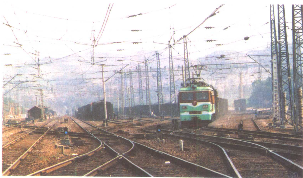
陇海线电气化铁路
