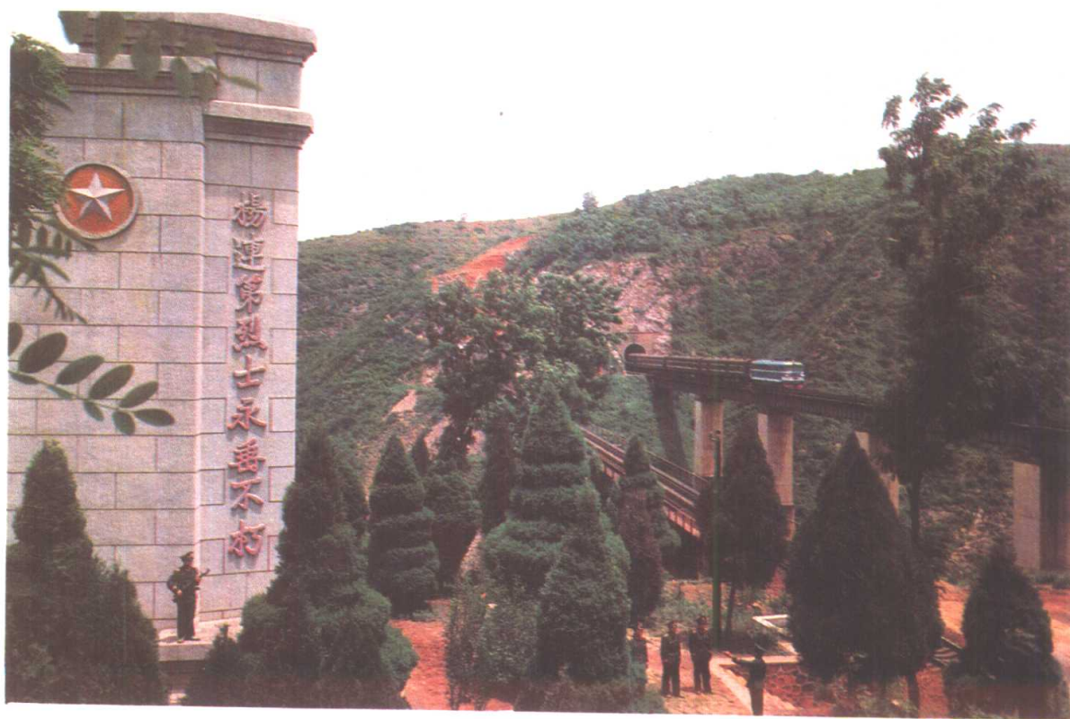
陇海线杨连第大桥
