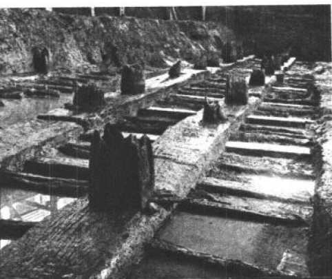
图一一 秦汉造船工场遗址一号造船台
