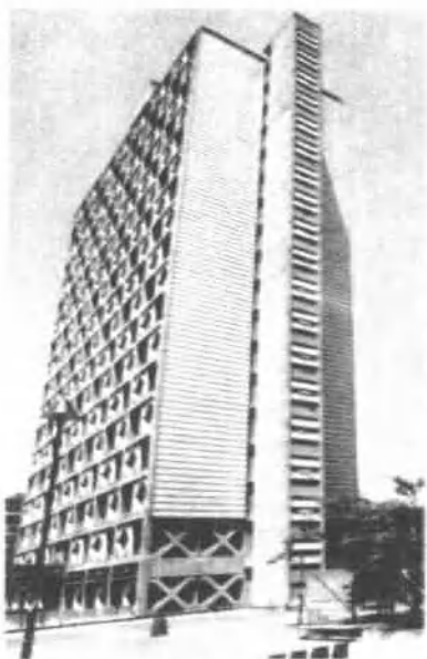
早稻田大学理工学部大楼。
