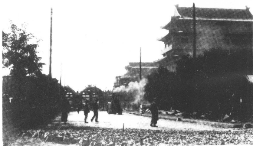
正阳门侧马路铺设石碴路
