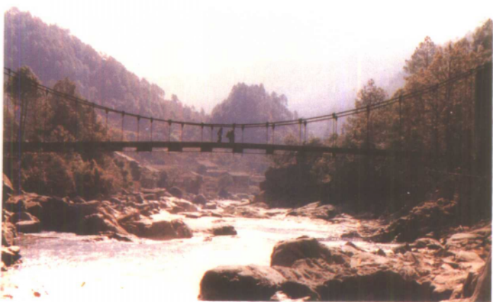
腾冲边境史迪威公路上的猴桥铁索桥
