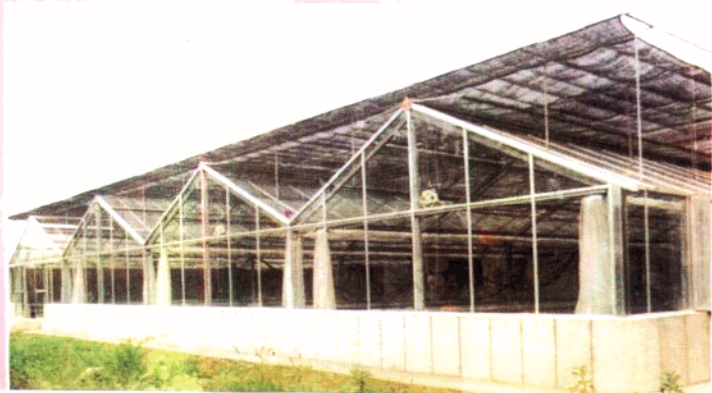
温室的外 遮阳设施
