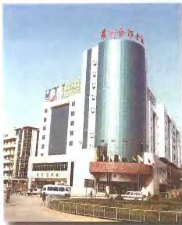
▲新落成前信用联社办公大楼
