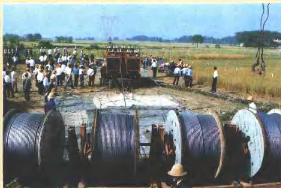
500千伏输电线 张力放线
