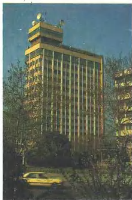
安徽电力调度大楼
