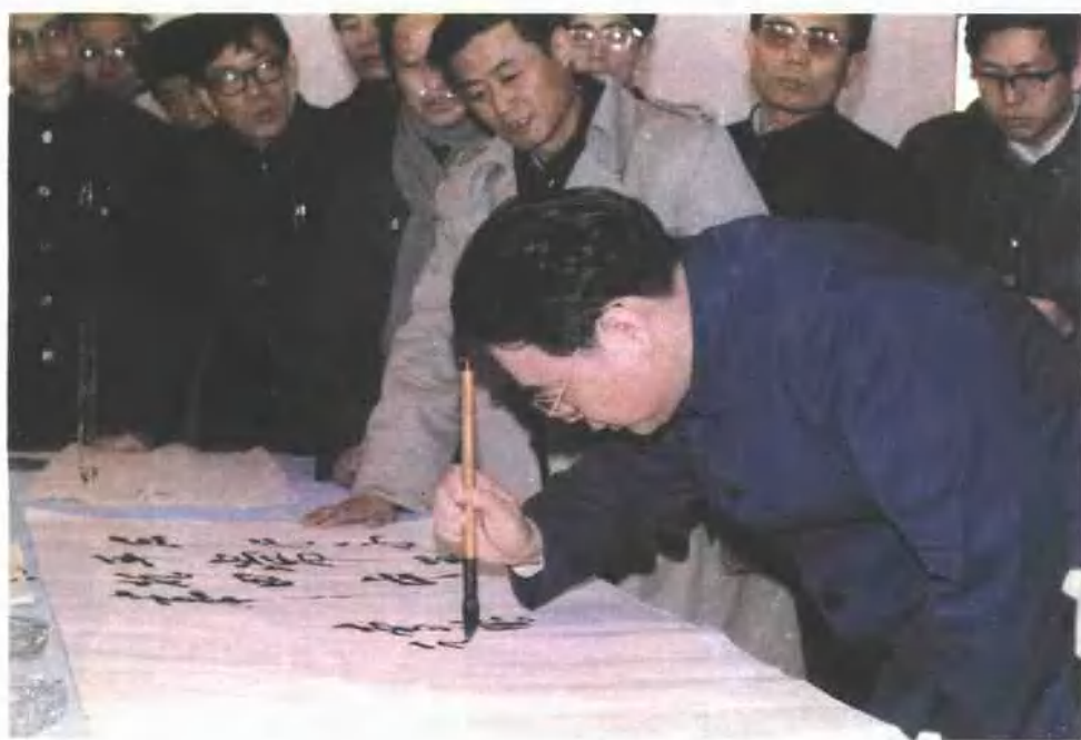
1985年3月9日李鹏副总理视察平圩电厂工地
