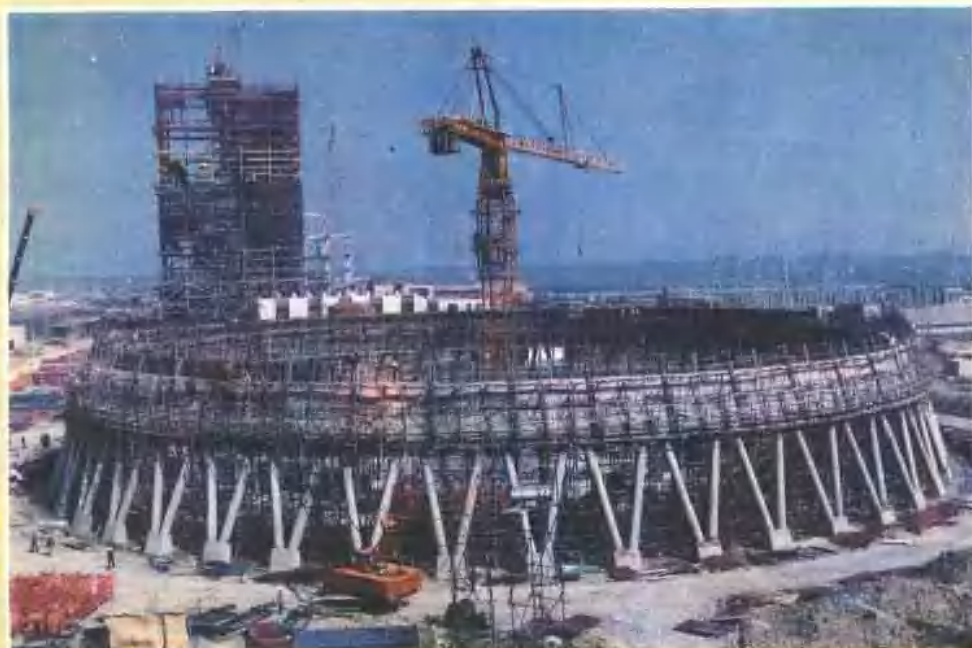
国产第一台60万千瓦发电机组在平圩建设中
