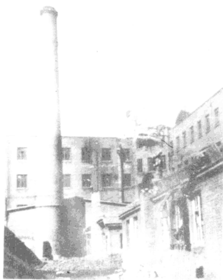
▲ 营口市革委会招待所楼顶倒塌
