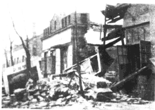
▶ 营口市站前饭店倒塌
