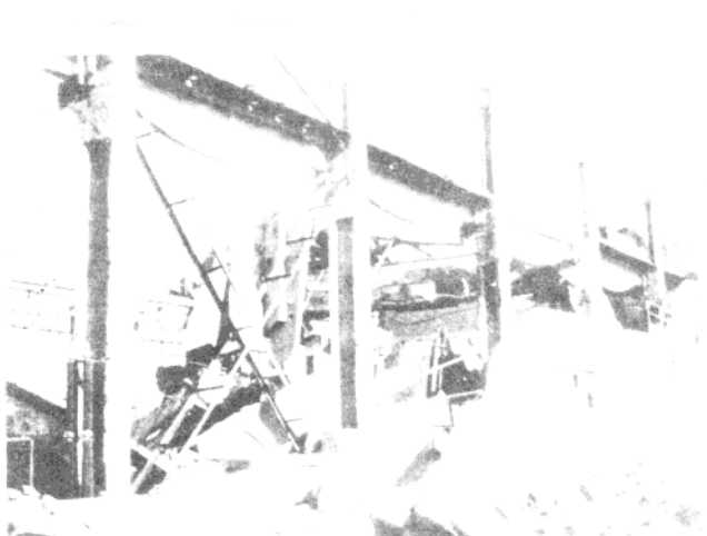
► 营口市老边区中板厂机修车间全部倒塌
