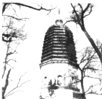
▲ 辽阳白塔地震时受损
