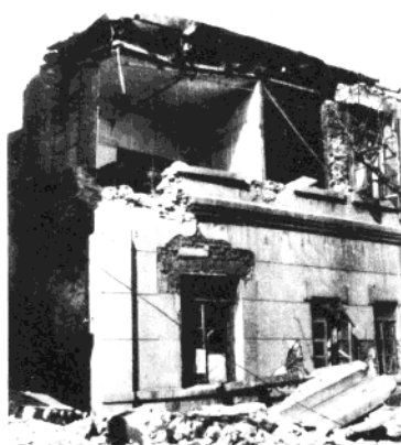
▶ 营口卫生局办 公楼震后破坏情景
