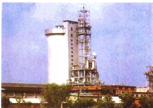
▲ 辽河化肥厂造粒塔，1972年施工时采用抗震措施，1975年海城地震时完整无损
