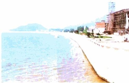
富春江西大道防洪大堤
