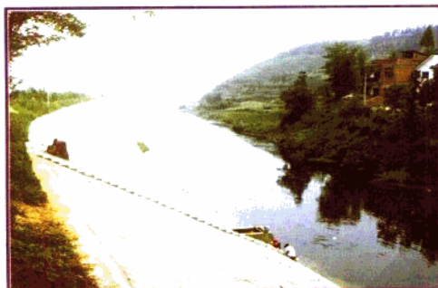
皇天畈北渠除险加固工程舒姑洋段
