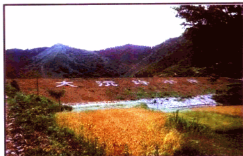
除险加固后的大源坞水库
