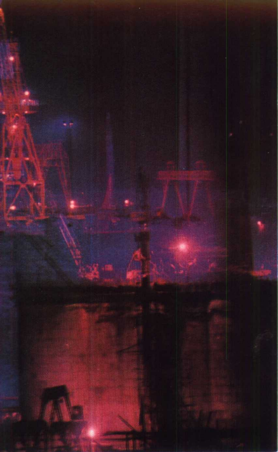
◀ 建设中的西柏坡发电厂
