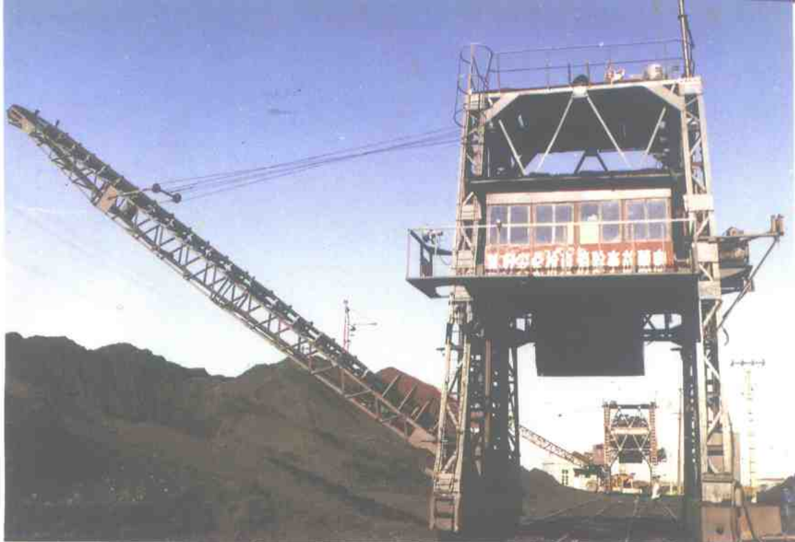
黑龙江省燃料公司煤场卸煤机
