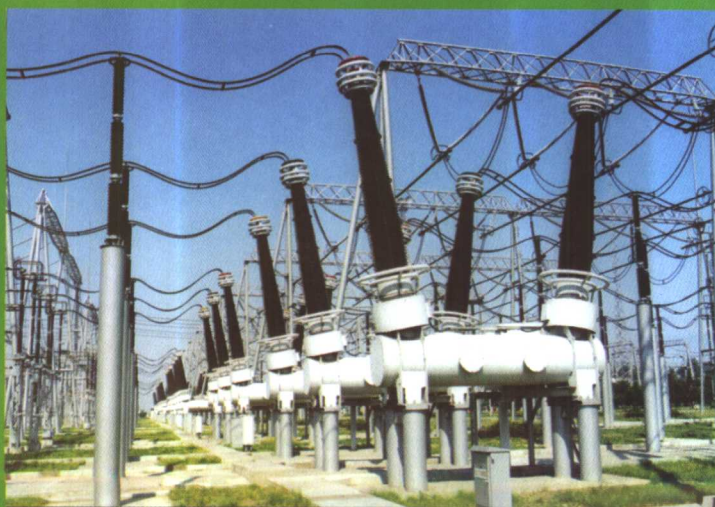
● LW12-500 型六氟化硫罐式断路器
