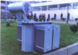
H级绝缘赛格迈(SECURAMID)干式配电变压器 SCR8-50-2000/10
