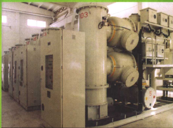
● ZF6-110 型六氟化硫封闭式组合电器
