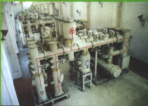
● ZF6-220 型六氟化硫封闭式组合电器
