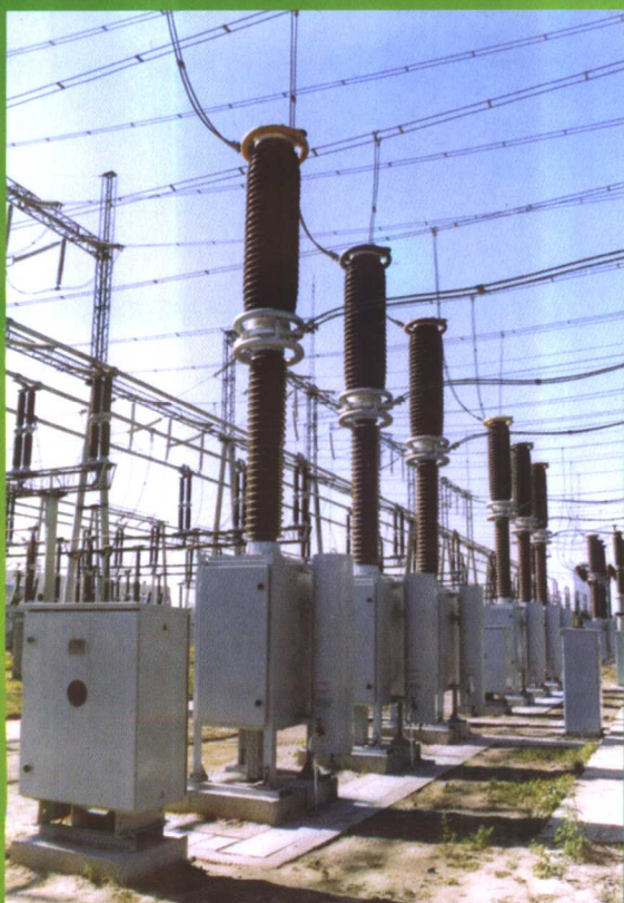
● LW11-220 型六氟化硫瓷瓶式断路器
