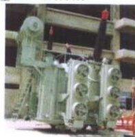
S9-50-31500/35 电力变压器
