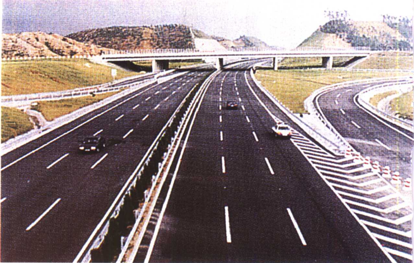
机荷高速公路 △
