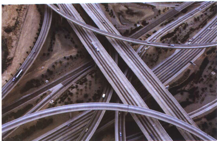
欧洲高速公路立交 △
