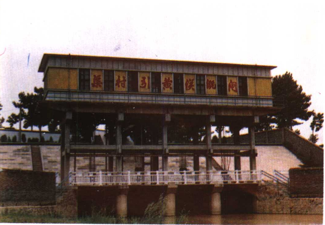
▼ 渠村引黄灌溉闸
