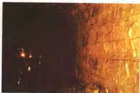
导流洞开挖光面爆破
