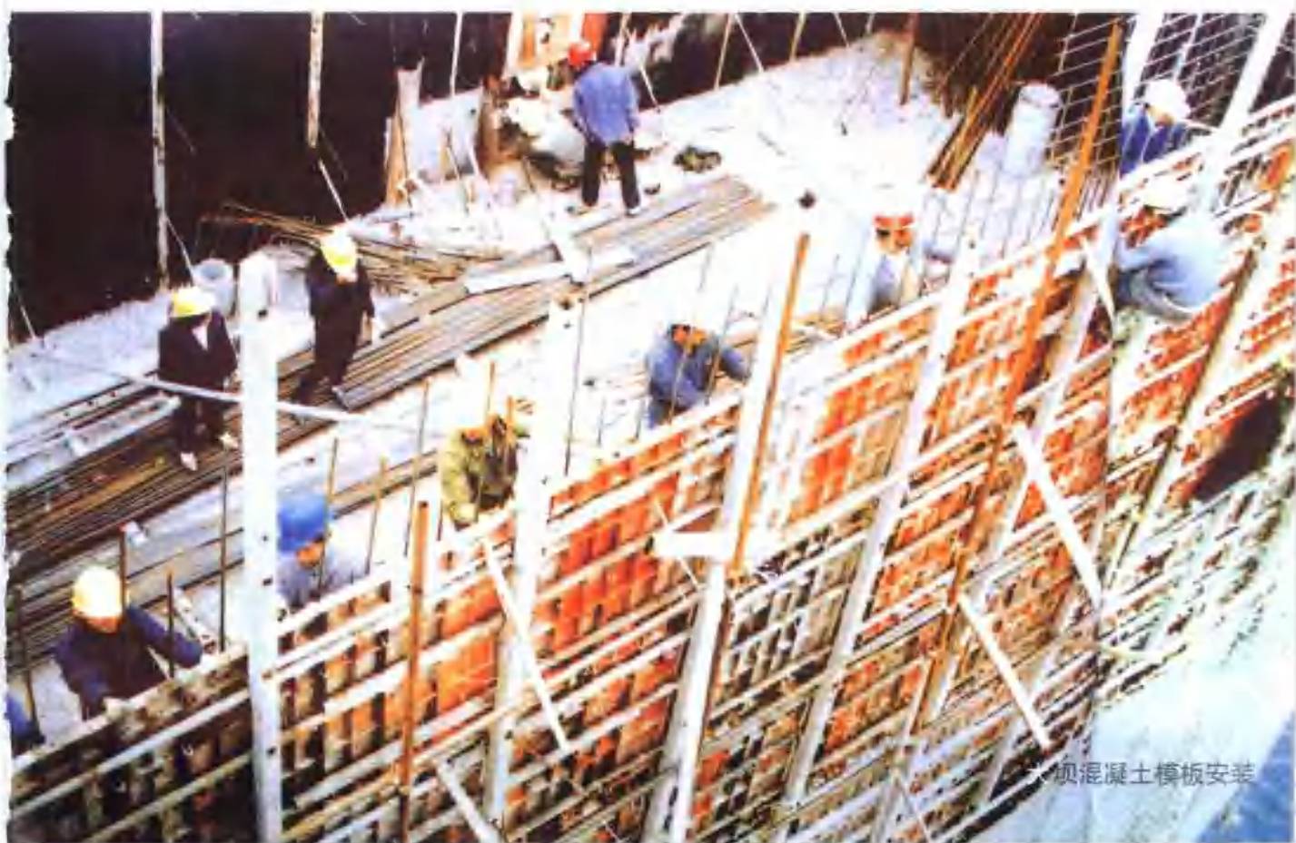
大坝混凝土浇筑
