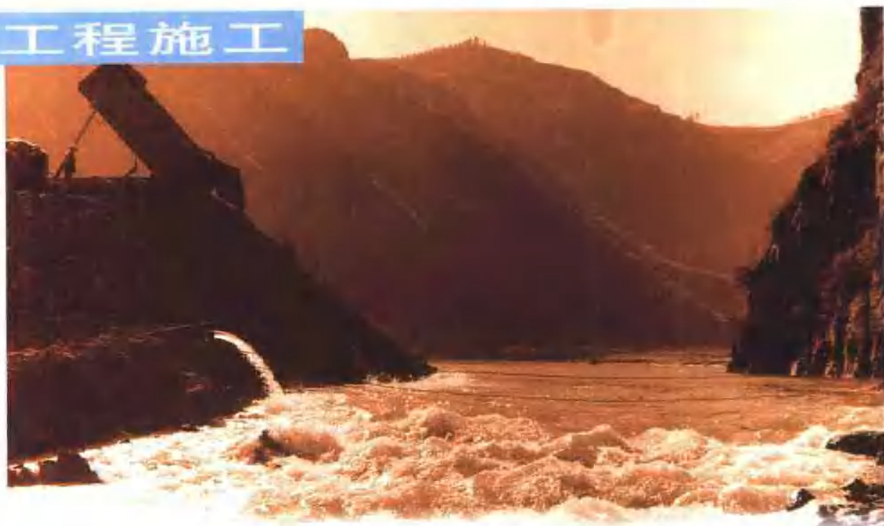
1980年8月截流施工
