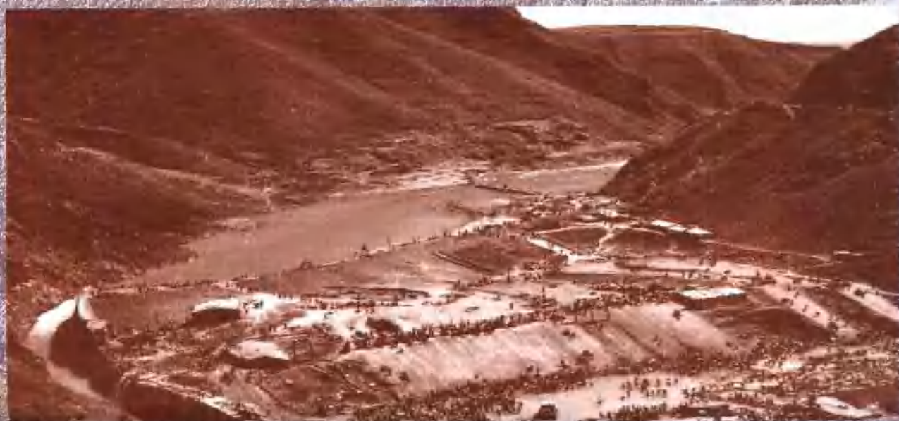
1973年故县水库第三次施工时开馆散水横场面
