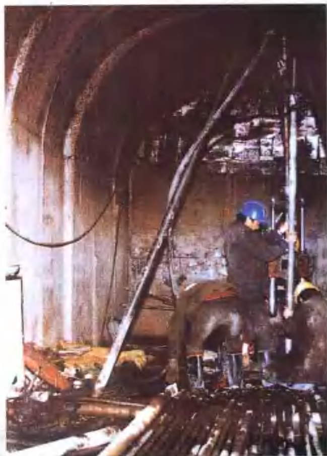
大坝基础帷幕灌浆施工
