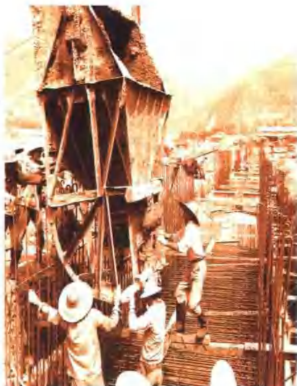
大坝混凝土浇筑
