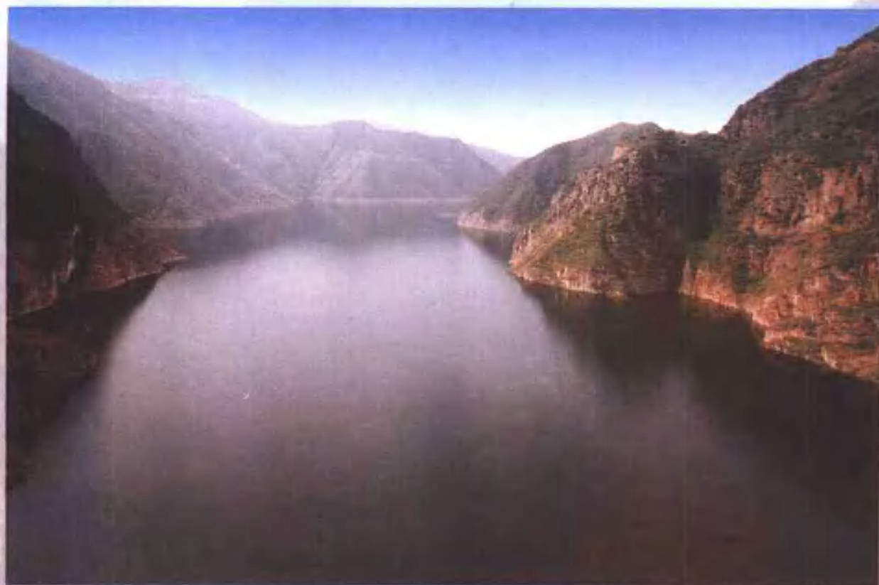
水库拦洪蓄水
