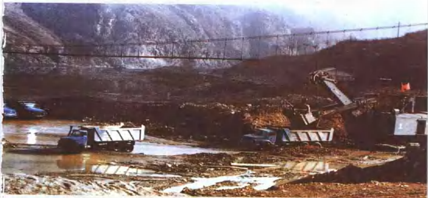
大坝基础开挖
