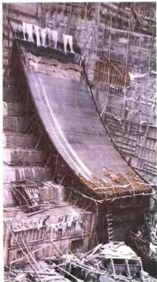
滑动模板浇筑大坝溢流面
