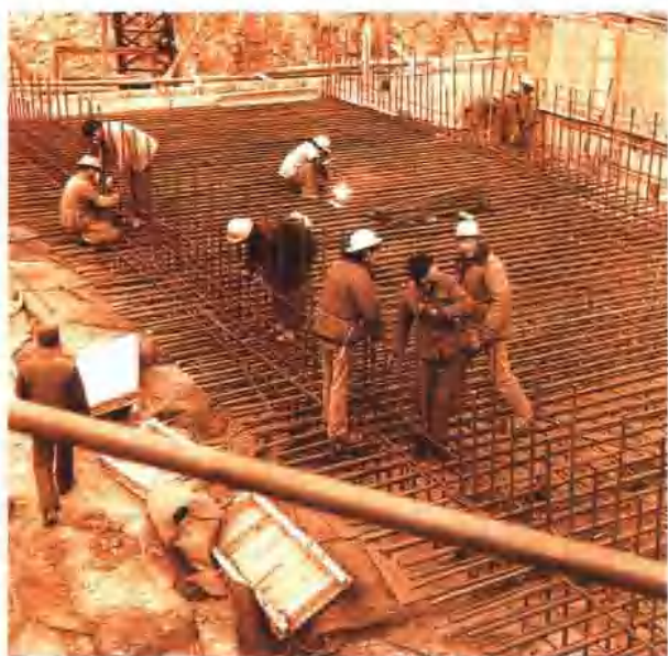
大坝钢筋入仓绑扎焊接
