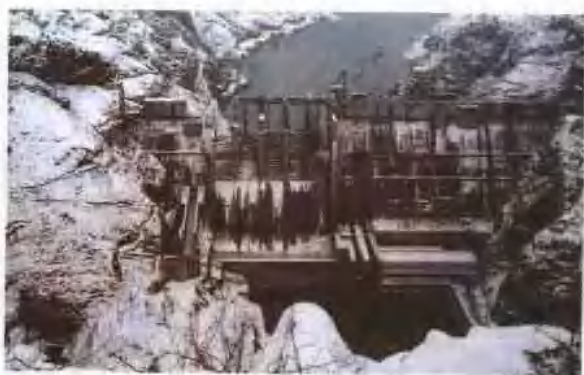
故县水库冬季施工
