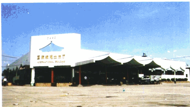
桂林机场国际航班出发厅。
