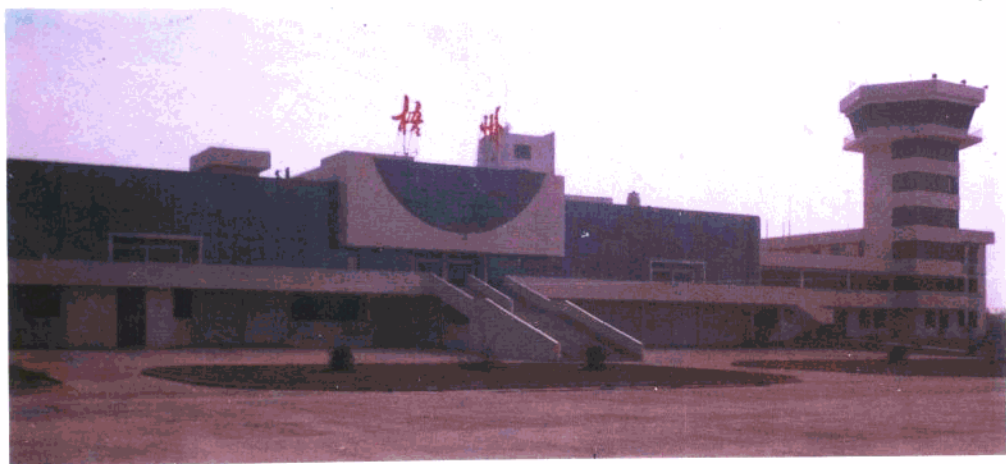
梧州长洲岛机场航管楼和候机楼。
