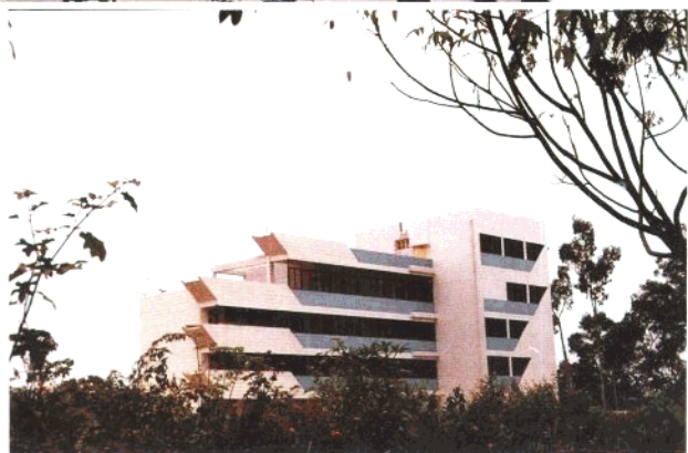
南宁机场通信大楼。
