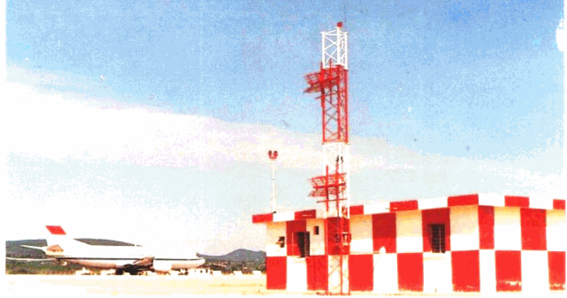
桂林机场盲降设施一角。
