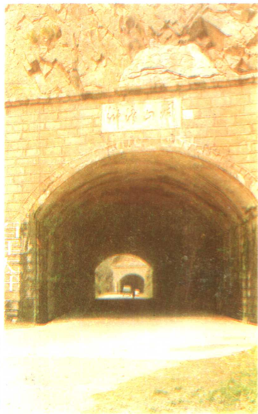
寨檀公路浒湾山洞
