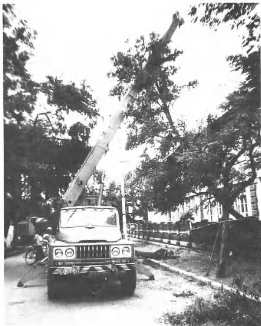
九号台风 刮断大连市内 高压电杆
