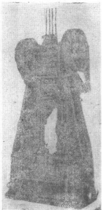
图3 夹板模鍛錘。
