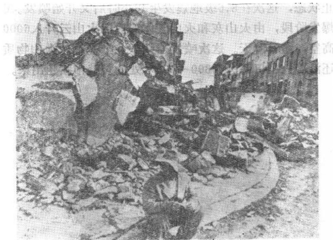
卡斯特罗市某大街楼房倒塌的情形
