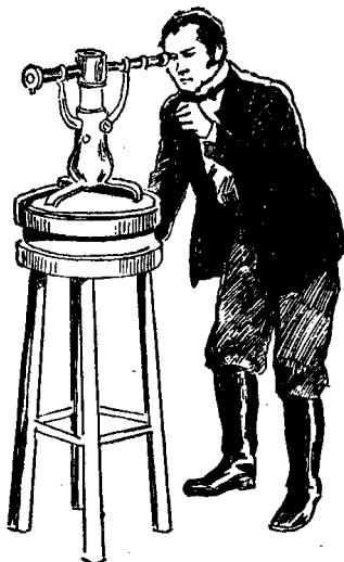
应该再研究一下太阳光。方和斐用一面镜子，把阳光反射进狭缝。他在太阳的光谱中找那两条明亮的黄线。可是没有，却发现太阳光谱中有许多黑线。方和斐仔细数了数，黑线有五百多条，有的深些，有的淡些。他给那些最深的最清楚的黑线，用 A、B、C、D、E 等编了号。
