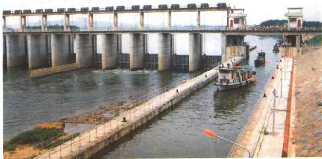
▽鲇鱼山渠化工程
