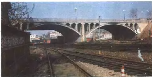
▷ 夜叉坞跨线桥
