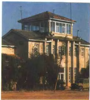
▷罗家民航机场通讯楼
