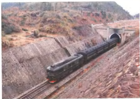
皖赣铁路界垅明洞
