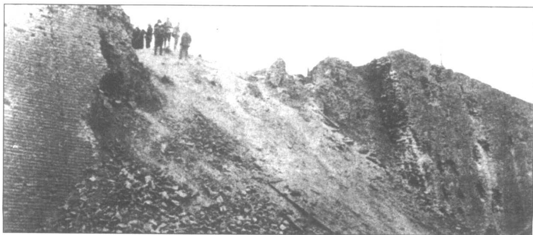
四野炮兵将敌十米高、八米厚的太原城墙打塌，为步兵打开了突破口。
