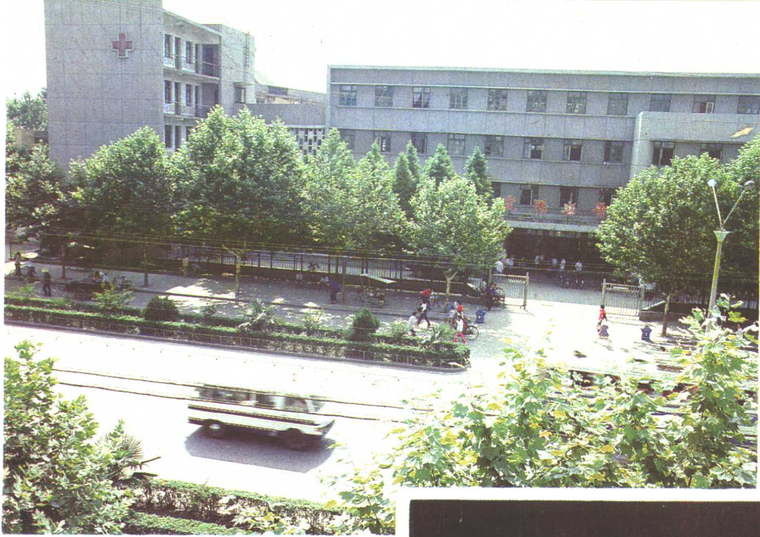
襄阳县人民医院 门诊大楼
