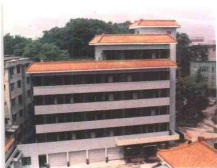
人防办公大楼
