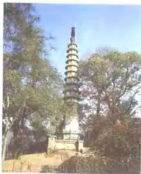
西泠印社华严经塔
